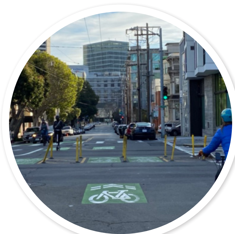
desviador de tráfico con postes flexibles
