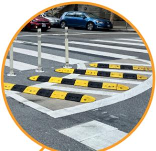
**帶有凸起標記物的塗漆轉角處理** 帶有凸起標記物的塗漆轉角處理沿著走廊的許多交叉路口都有黑色和黃色的凸起。這些處理減緩了駕駛者的轉彎速度，而且在行車道和腳踏車道之間增加了額外的物理分離。
