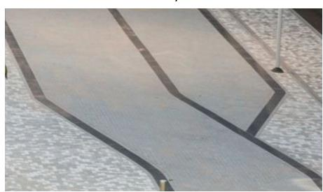
**DRAINAGE FEATURE: SLOT DRAIN**
